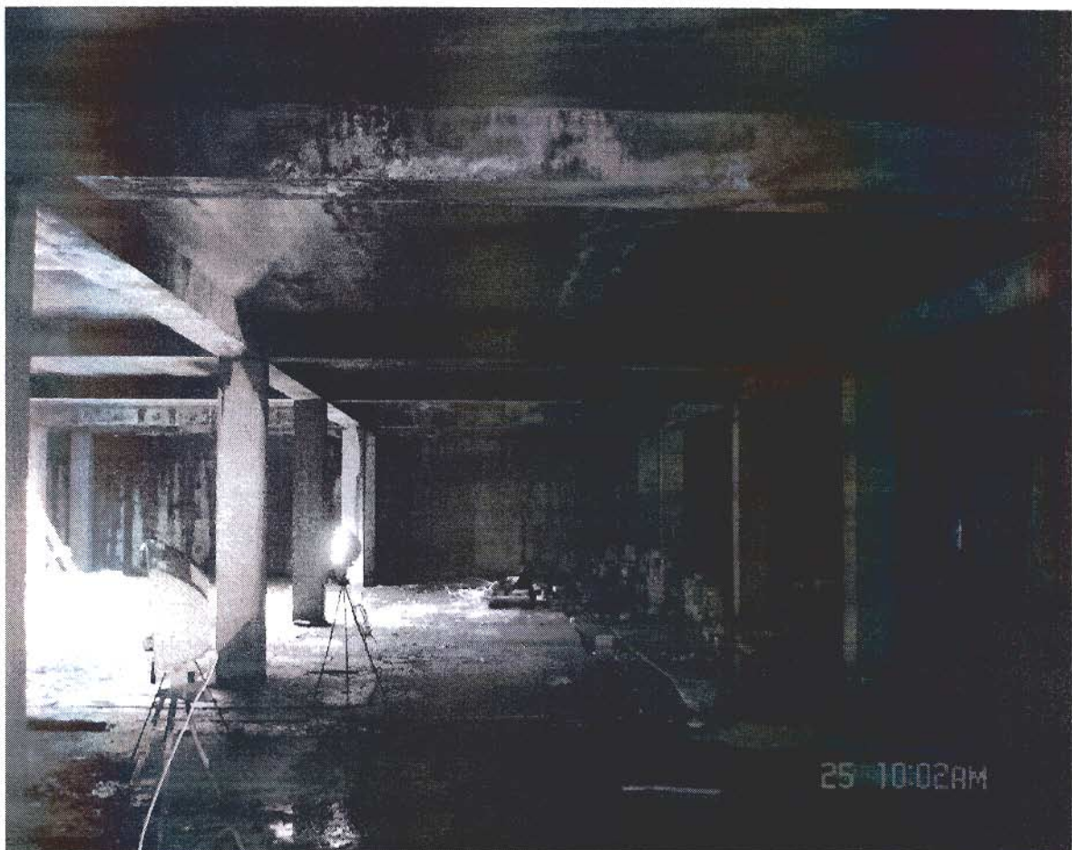
Рис.3. Общий вид помещения подземного гаража, вид железобетонных конструкций снизу
