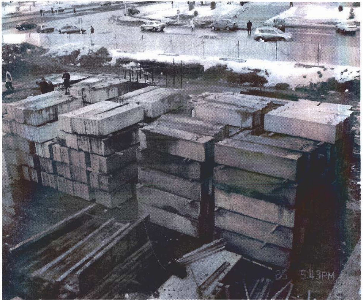
Рис. 5. Общий вид ячеек покрытия при полной испытательной нагрузке
